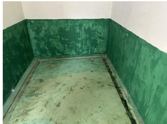
一般固废暂存间内部
