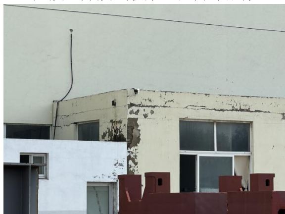
危废仓库外部摄像
