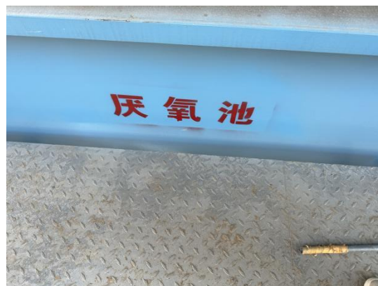
生化池（厌氧池）
